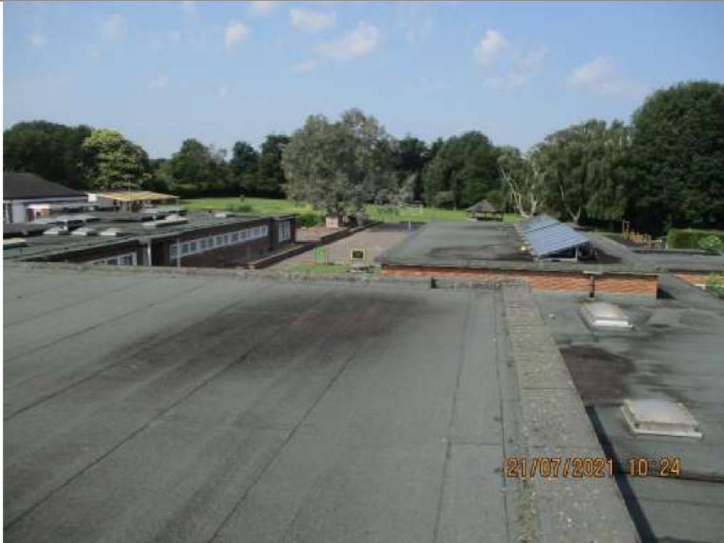
35) Roof above hall.
