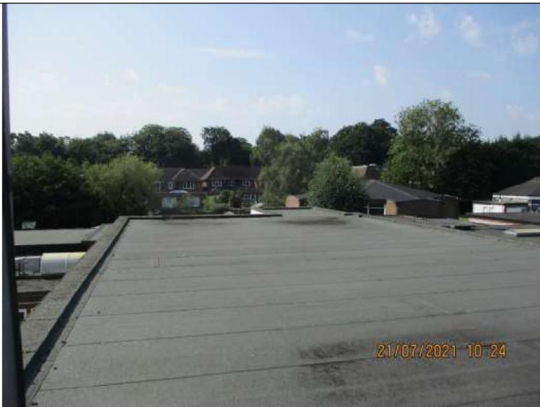
34) Roof above hall.
